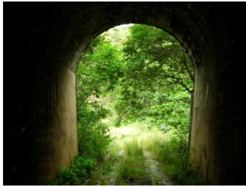
Túneis da antiga linha férrea Paracatu/Belo Horizonte
